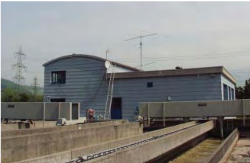
Beam auf dem Betriebsgebäude der ARA Glarnerland
